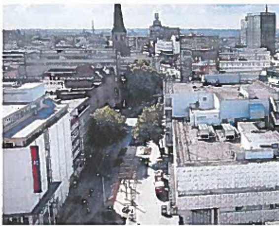
Das Thema „Zweiter Rettungsweg“ sorgt dafür, dass der Weiterbau des Boulevards Kampstraße in der City nicht wie zunächst geplant vorankommt. fotograf.com (A) BANDERMAN
